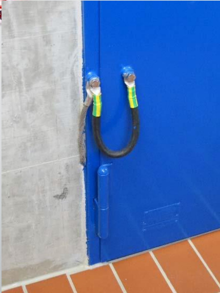
همبندی درب اتاق ترانسفورماتور با سازه فلزی ساختمان
